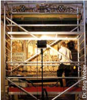
Arbeiten am Bürgermeisteraltar
